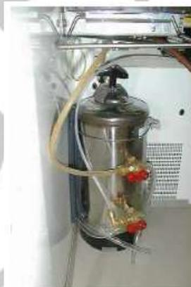
В случае установки фильтра, смягчающего воду, следует измерить твердость воды (с помощью специального устройства, доступного на рынке), чтобы определить, как часто надо будет обновлять фильтр. Это зависит от степени изношенности фильтра и твердости воды (подробности в разделе „Обновление фильтра, смягчающего воду”).
